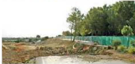
Carretera de Son Servera-Cala Millor afectada por las obras del tren. B. C.
